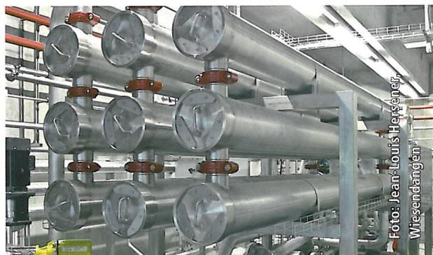
Abb. 3 | Umkehrosmose-Anlage.
