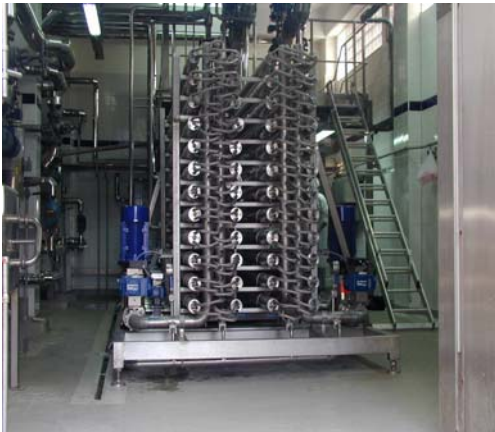
Bild 5: ENVIROCHEMIE® NFI für Laugerecycling
